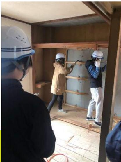
手作業で内部の壁や収納を壊しました。解体完了後の室内風景。
